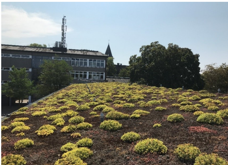
Gründach auf dem Marie-Curie-Gymnasium, Gräulinger Straße 15 (Foto: Halbe)
